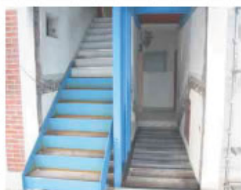
2007.3月 階段室施工
