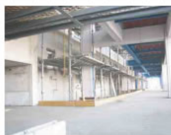
2007.2月 共用廊下コンクリート打設
