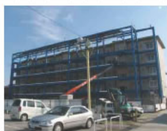
2007.2月 鉄骨建方(北面)
