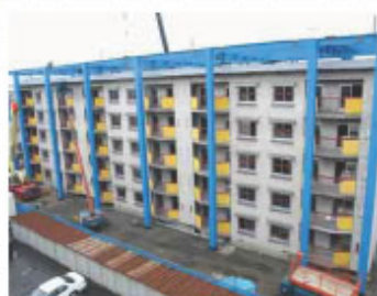
2007.2月 鉄骨建方(南面)
